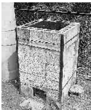
ブロック積簡易焼却炉
